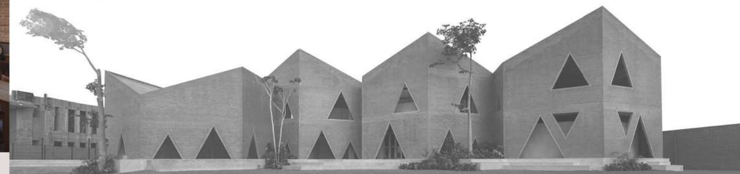
COLÉGIO MARIA MONTESSORI - México EPArquitectos, Estudio Macías Peredo
